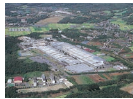
伸銅所(現 UACJ銅管 伸銅所)
