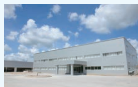
建設中のタイ工場
